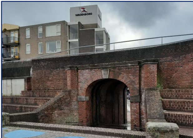
Grote Waterpoort open, gezien vanaf de kade
